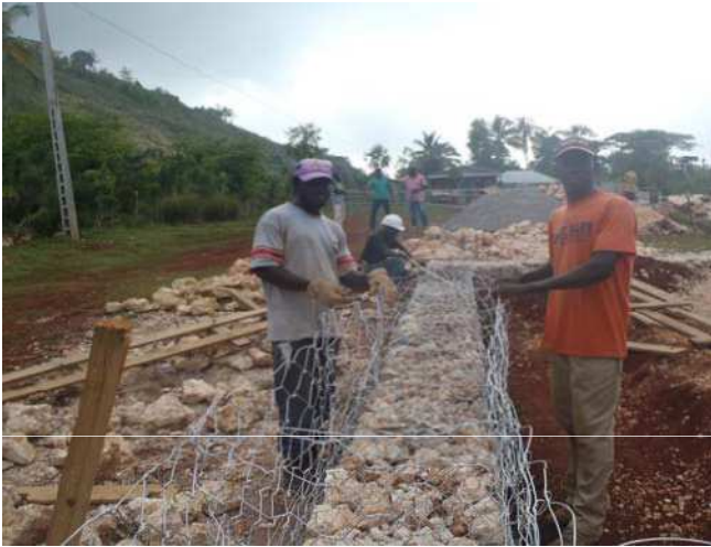
POSE ET ASSEMBLAGE DES TRESSSES EN "U"
