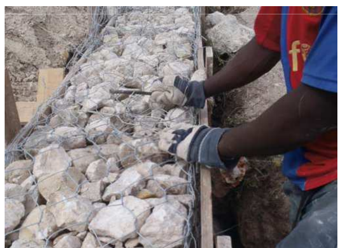
POSE DE LA TRESSE DU COUVERCLE EN ATTENTE
