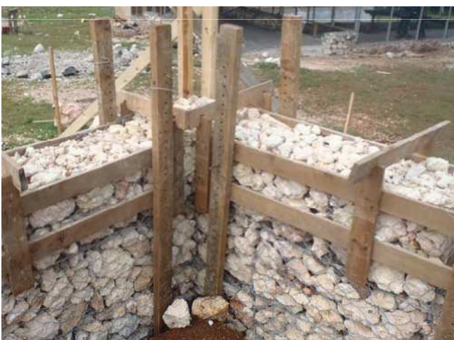
REPLISSAGE DE LA DEUXIEME MOITIE DU RANG
