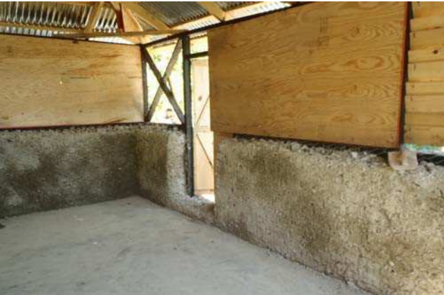
COFFRAGE INTERIEUR EN CP
