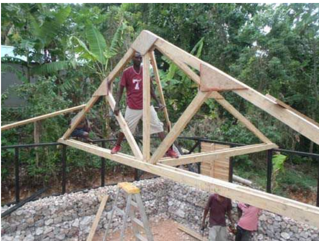
POSE DES DEMI-FERMES Centrage, alignement et niveau selon plan de pose
