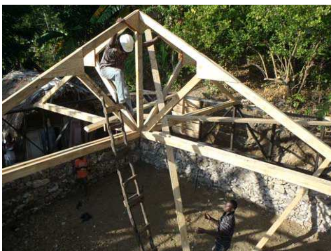
POSE DES DEMI-FERMES Centrage, alignement et niveau selon plan de pose
