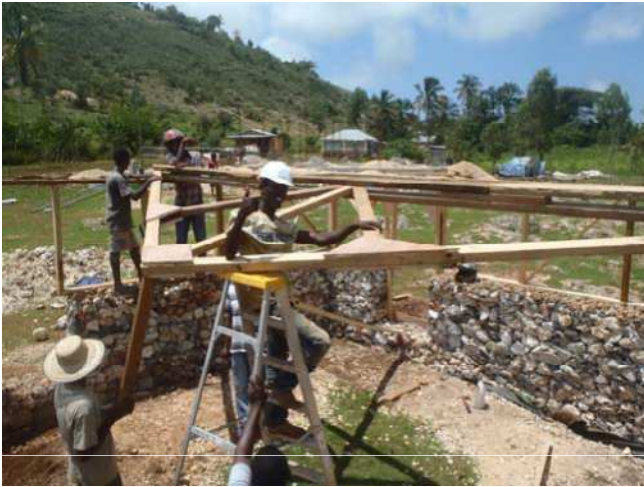
LEVAGE ET REGLAGE DE LA FERME Centrage et niveau
