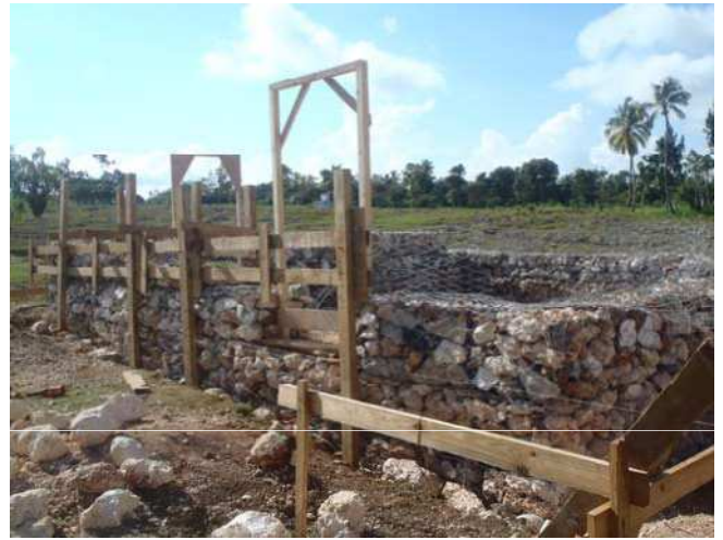
POSE DES COFFRAGES DE REMPLISSAGE DE Microgabion
